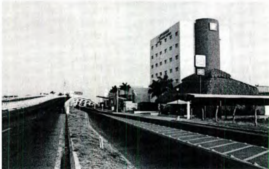
Imagen 2.19 3er Anillo Periférico de la Ciudad de Colima. Fuente: Acervo fotografica del H. Ayuntamiento de Colima, 2013.
